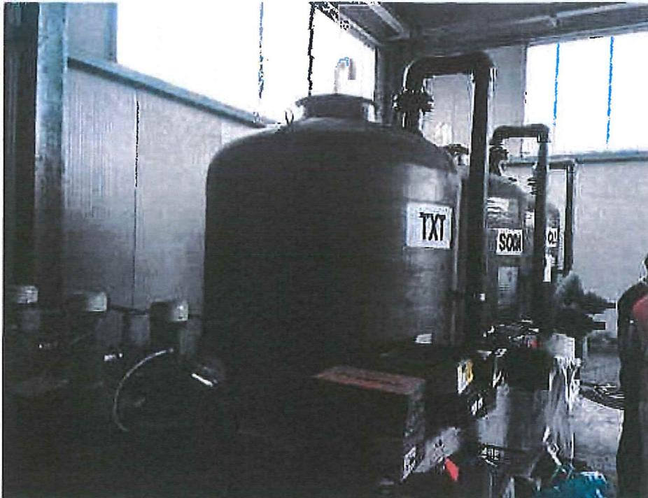
STOCCAGGIO COAGULANTI LOCALE TECNICO SEZIONE 1
